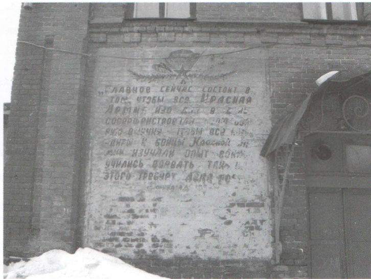
Сохранившийся текст патриотического воззвания к воинам Красной Армии на восточной стене здания по ул. Сергеева-Ценского, 2. В годы Великой Отечественной войны в нем располагался госпиталь № 1189.
